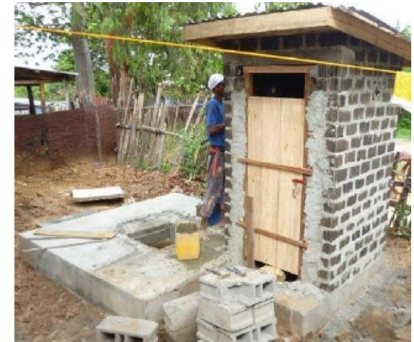
Figura: letrinas construidas con ladrillos de arena y plástico de la «Plataforma Re-source»
